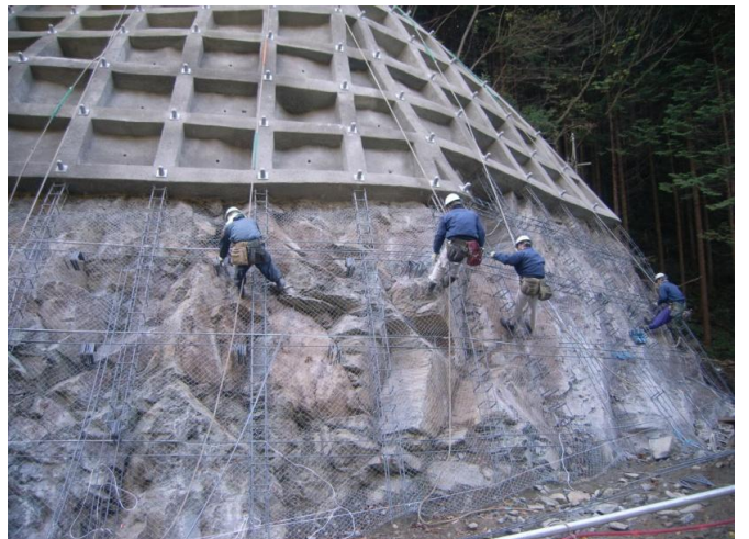
3回目の吹付法砕工の作業を開始しました。
