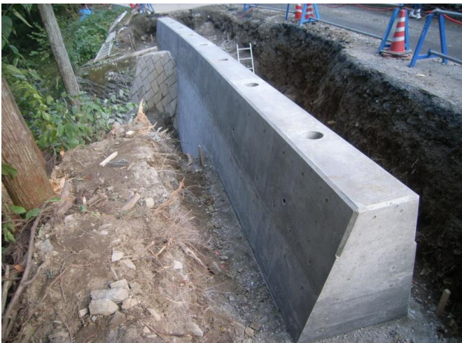
道路脇の擁壁を作成しました。
