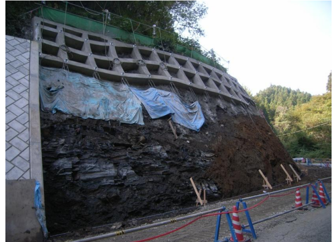
3回目の法切りが完了しました。
