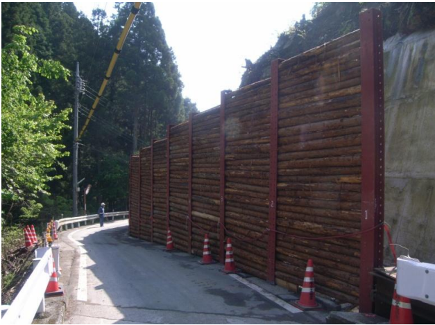
仮設防護柵の設置をしました。
