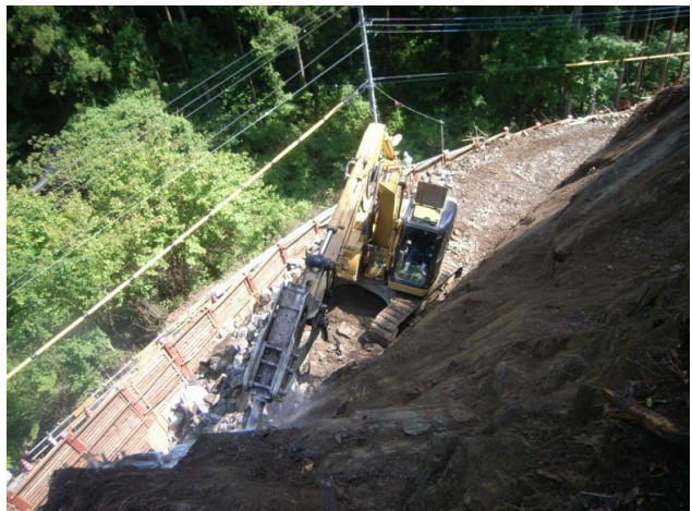
ブレーカーにて岩盤を壊しているところです
