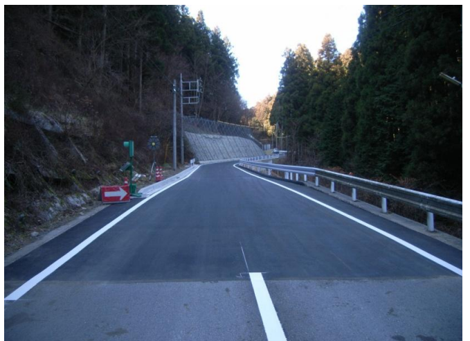
完成の写真です。藤岡方面から
