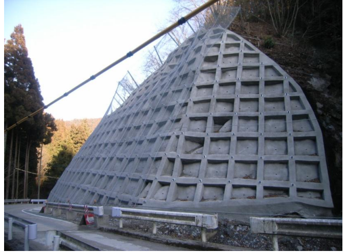
完成の写真です。栲山方面から
