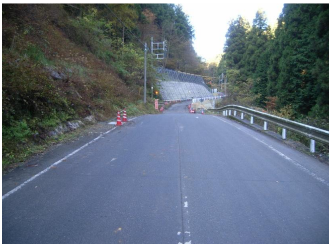
施工前の写真です。栲山方面から
