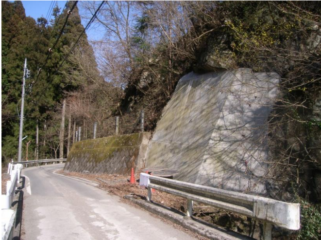
施工前の写真です。栲山方面から
