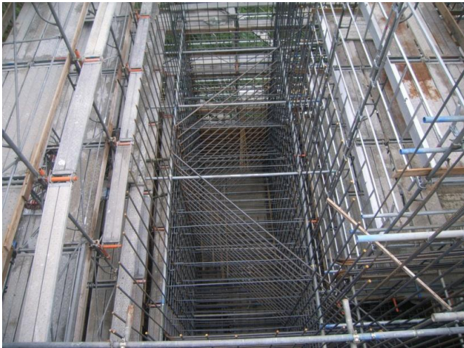
鉄筋と型枠が完了しました。
