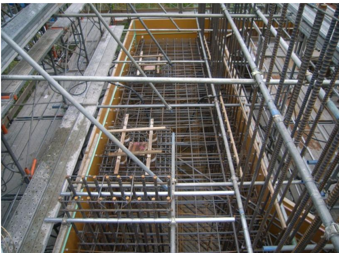
鉄筋と型枠が完了しました。
