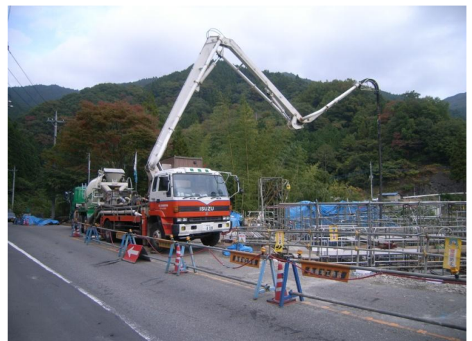
ポンプ車にてコンクリートを打設しています。
