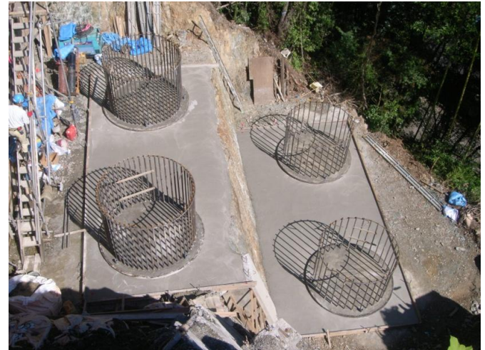
コンクリート打設が完了しました。
