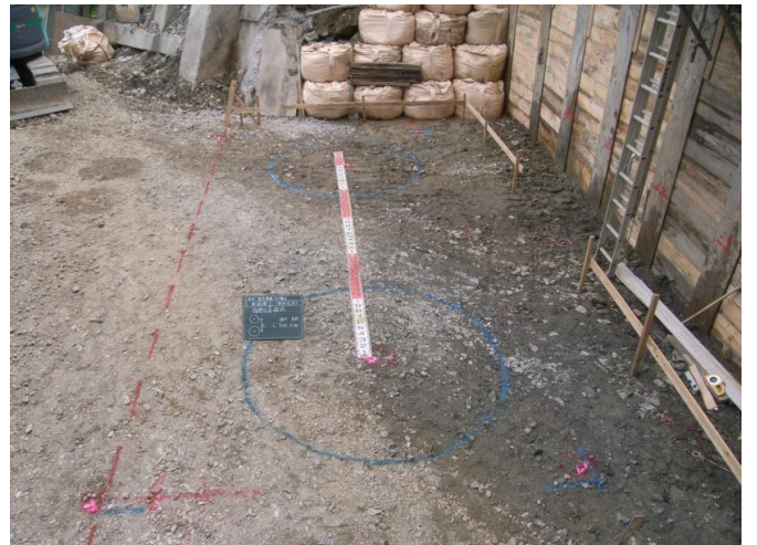
これから深礎工を施工します。
